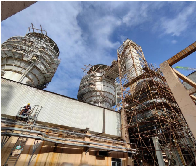
华能临沂电厂#2 脱硫一二级塔联络烟道和#7 脱硫原烟道隐患治理工程
