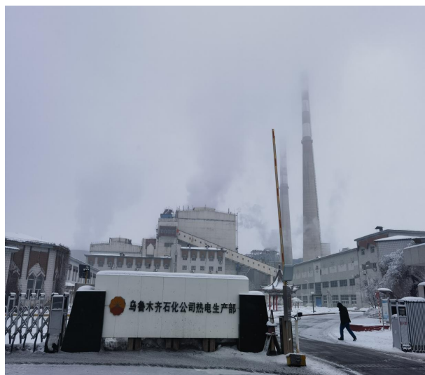
乌石化热电生产部 2023 年 2 号烟囱及烟道隐患治理
