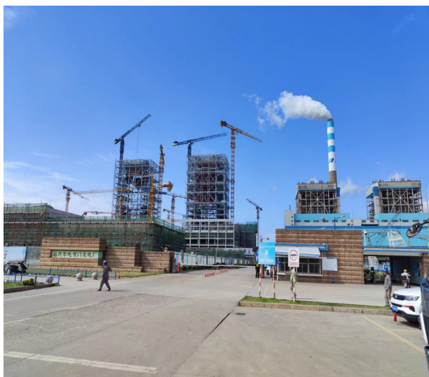
福建华电可门发电有限公司二期烟囱航标刷漆施工
