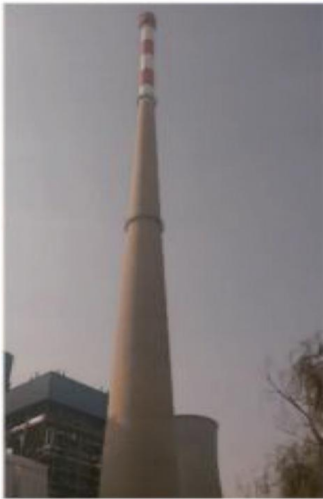
华能淄博白杨河发电有限公司 2×145MW 机组超低排放改造项目烟囱 防腐改造
