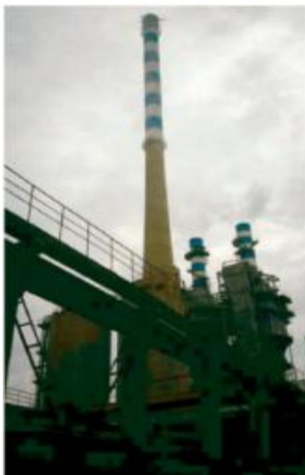
淄博鑫胜热电有限公司 150 米烟囱内防腐工程
