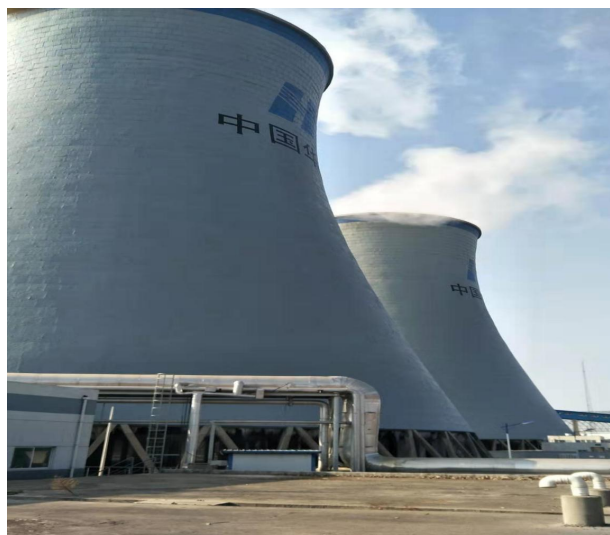
华能辛店#5 机组 A、B 凉水塔外壁防腐工程
