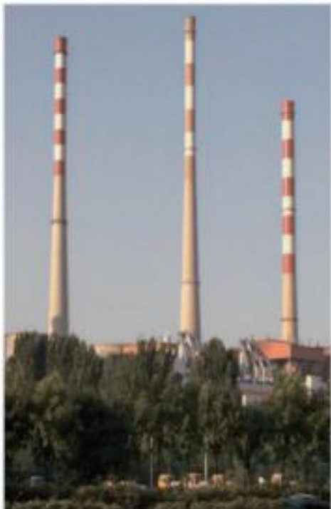
华能济宁运河发电有限公司 1、2 号 2×145MW 机组超低排放改造工程 烟囱防腐改造
