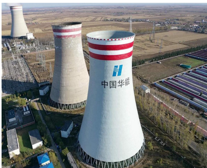
华能鹤岗发电有限公司 1 号水塔内外壁防腐
