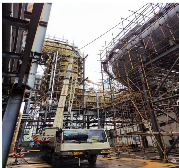
华能上海石洞口第一电厂炉后烟道防腐
