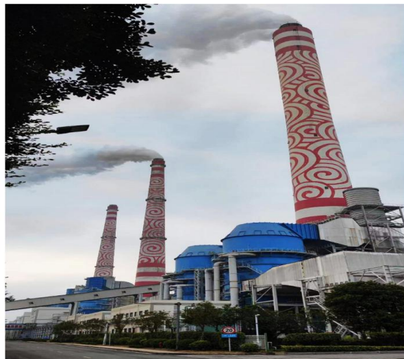
华能福州电厂三期烟囱防腐改造施工工程
