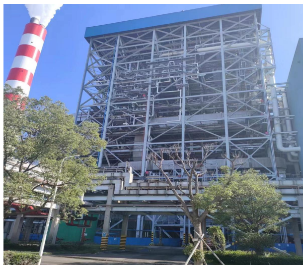
华能玉环 1 号和 2 号机组锅炉防腐工程
