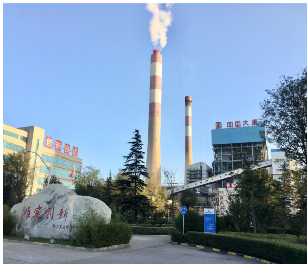
大唐韩城第二发电有限责任公司一期烟囱1号烟囱240米内壁防腐工程
