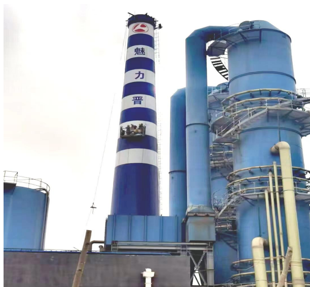
冀融(晋州)清洁能源有限公司烟囱防腐工程施工
