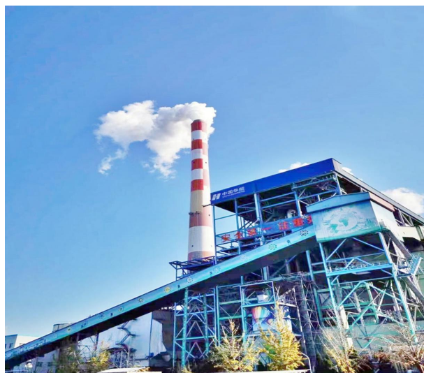
华能上安电厂 2 号烟囱文明整治工程
