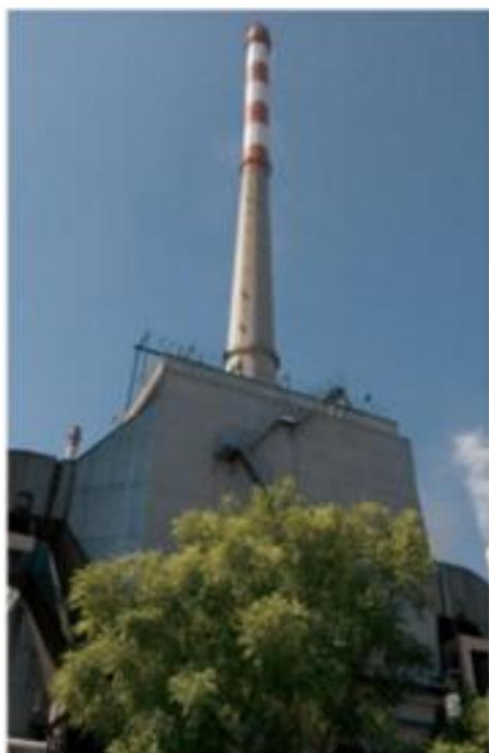
华能临沂发电有限公司 一期 210 米烟囱防腐施工
