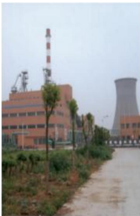
江苏射阳港发电厂 二期 210 米烟囱防腐施工
