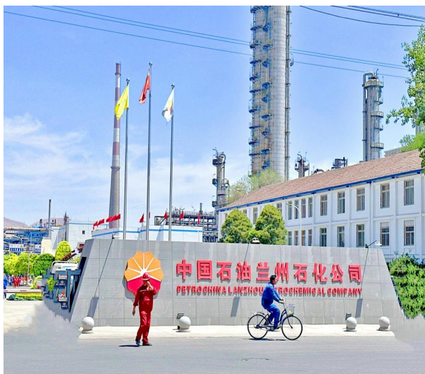
兰州石化公司公用工程二部 AB 锅炉装置 2023 年大检修烟内外部防腐项目
