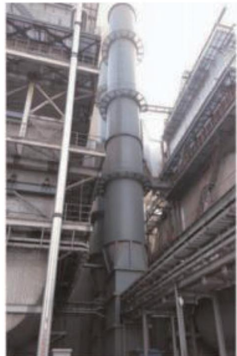
华能日照电厂 检修钢烟囱制作安装工程
