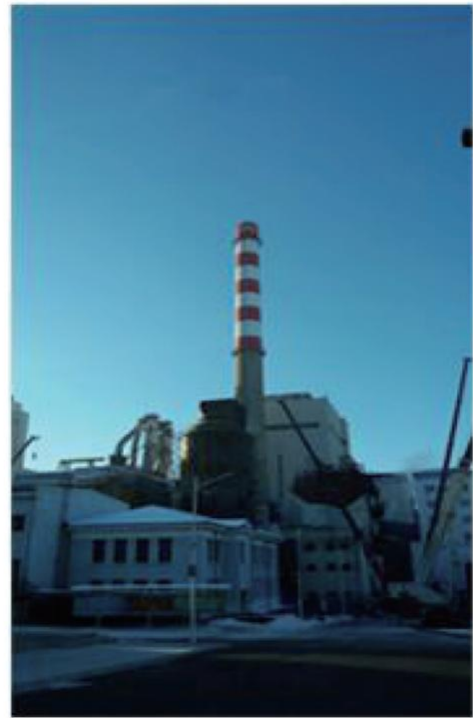
华能新华发电有限公司 二期烟囱防腐改造
